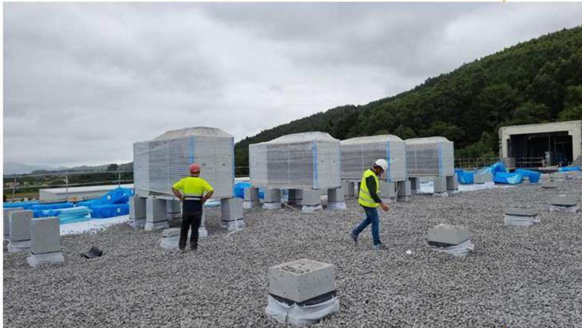
Producción de agua caliente a 90 °C para proceso y usos sanitarios mediante bombas de calor TECNA ENERBLUE IRIDIUM 150, con refrigerante natural R744 y recuperación de frío en la nueva sede de la industria farmacéutica FAES FARMA en Bizkaia
